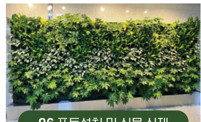
06 포트 설치 및 식물 식재
