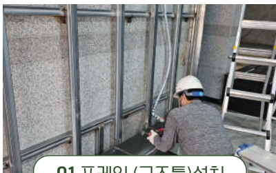
01 프레임 (구조틀) 설치
